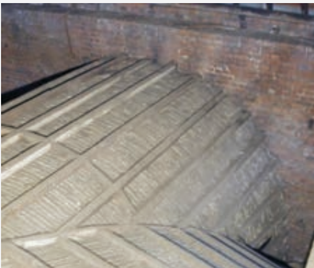
Houten structuur van de gewelven en detail keramische elementen.
