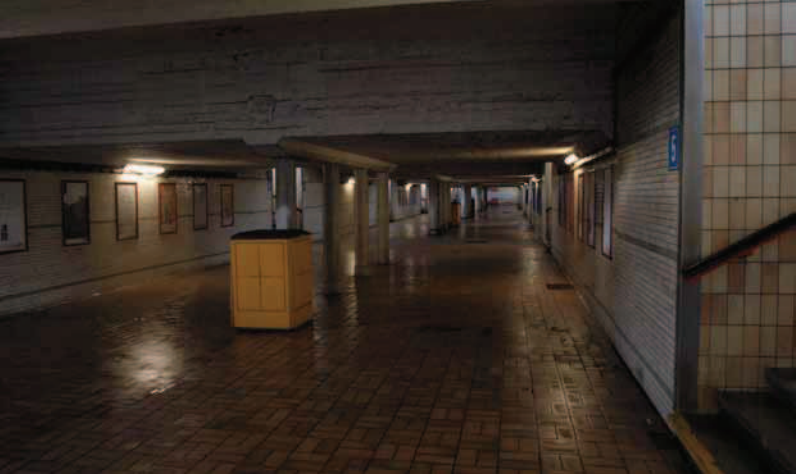
Tunnel de la gare Schaerbeek-Voyageurs: cul-de-sac
