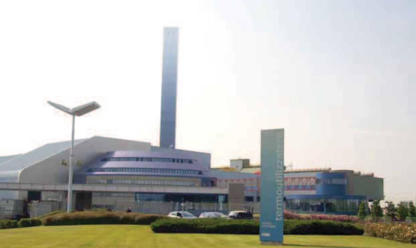
Incinérateur, Brescia : par un jeu de couleur, la cheminée se fond dans le ciel.
