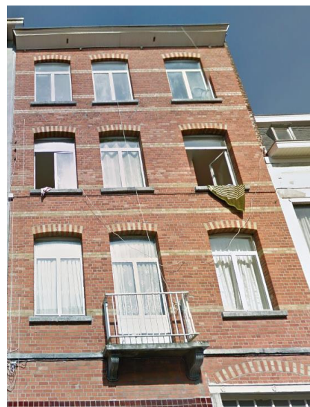
Figure 1 : Exemple de raccordements apparents sur une maison Bruxelloise (Rue des Béguines, Molenbeek-Saint-Jean) (Source : Google Street View)
