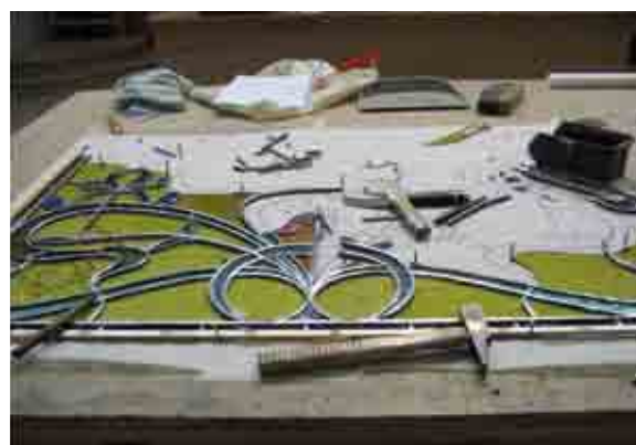
Restauration en atelier d'un vitrail.
