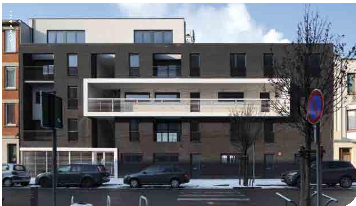
Immeuble de logements avec jardin, avenue Rodenbach 14-18 – CQ Princesse Elisabeth
