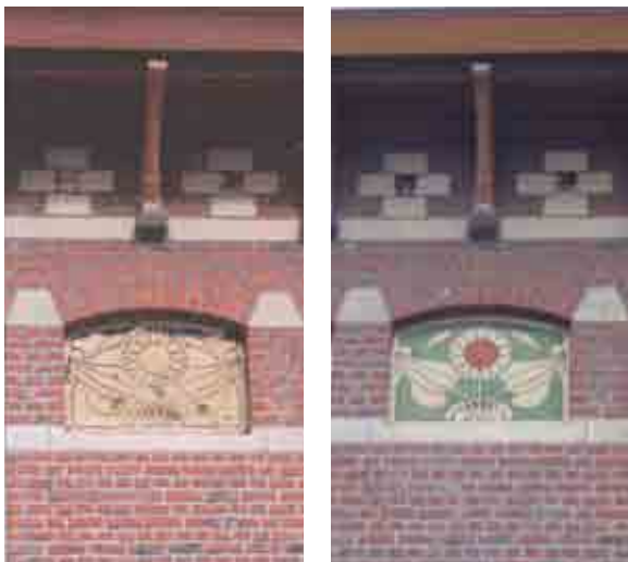
Sgraffite à Saint-Gilles, avant et après restauration.
