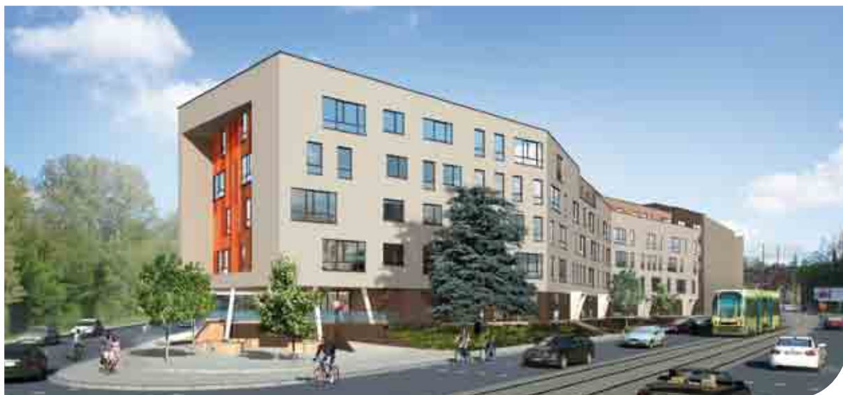
Août 2011 : délivrance du PU relatif au projet « Bourdon », à Uccle. Construction d'un ensemble de 68 logements (34 sociaux et 34 moyens). Début du chantier en 2011 également (Bureau d'architecture BEAB).
