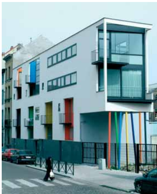
Rue des Quatre-Vents 182-190b, Molenbeek. Architecte: Pierre Blondel.
