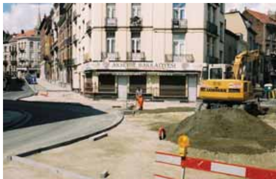
Aménagement de l'espace public du quartier Jérusalem.
