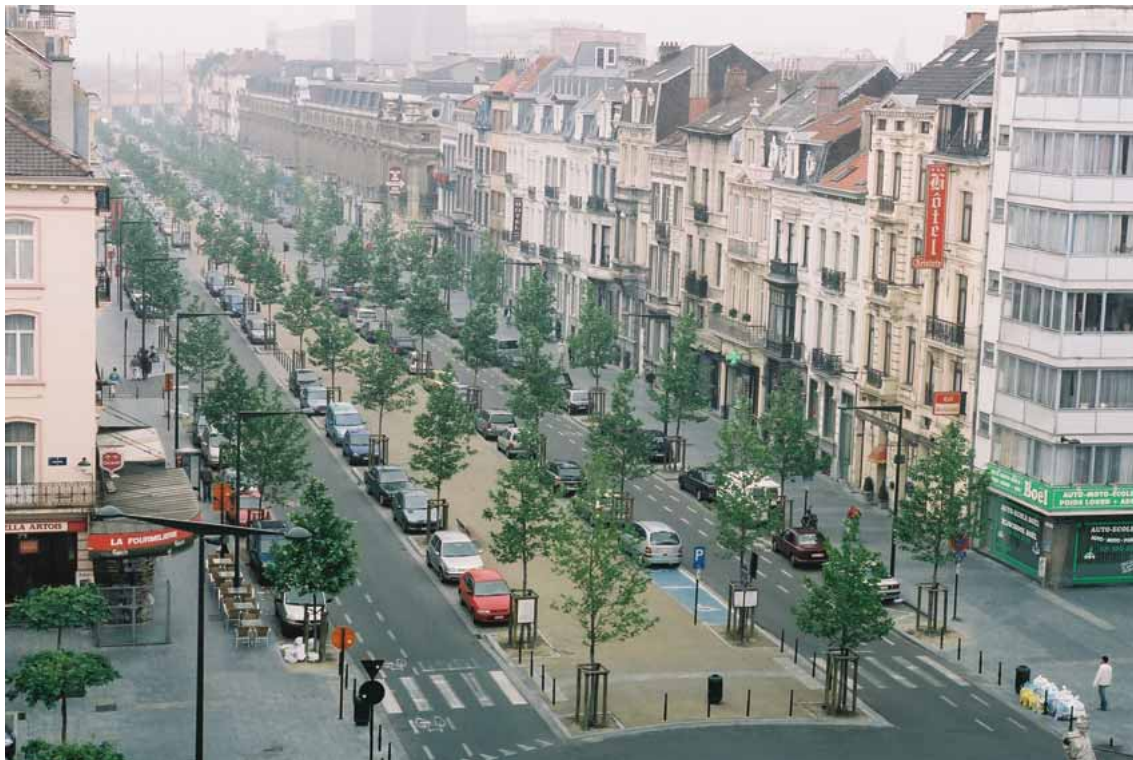
Réaménagement des espaces publics de l'Avenue de Stalingrad.
