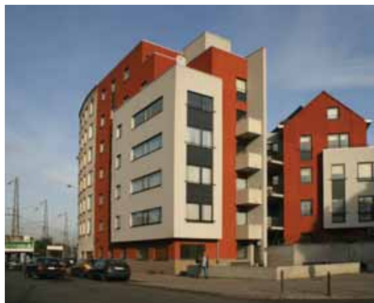
Angle rue des Palais 193-199 et rue Van Schoor 3. Architecte: Frédéric Huwaert.
