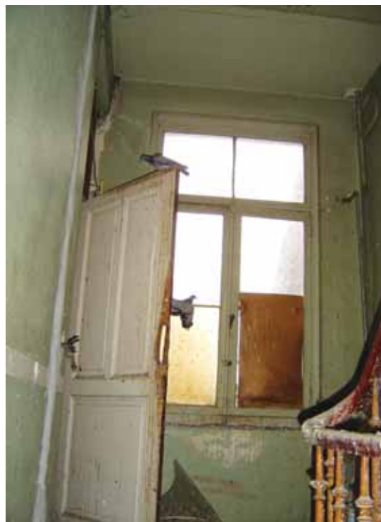
Vue du pallier du 2ème étage; le premier étage est loué et occupé
