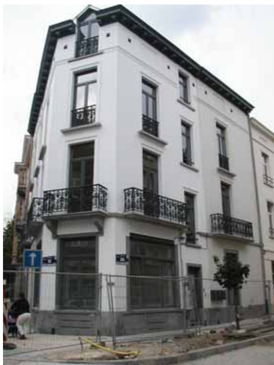
Rue des Cygnes 31-37, Ixelles. Architecte: service communal d'Ixelles.
