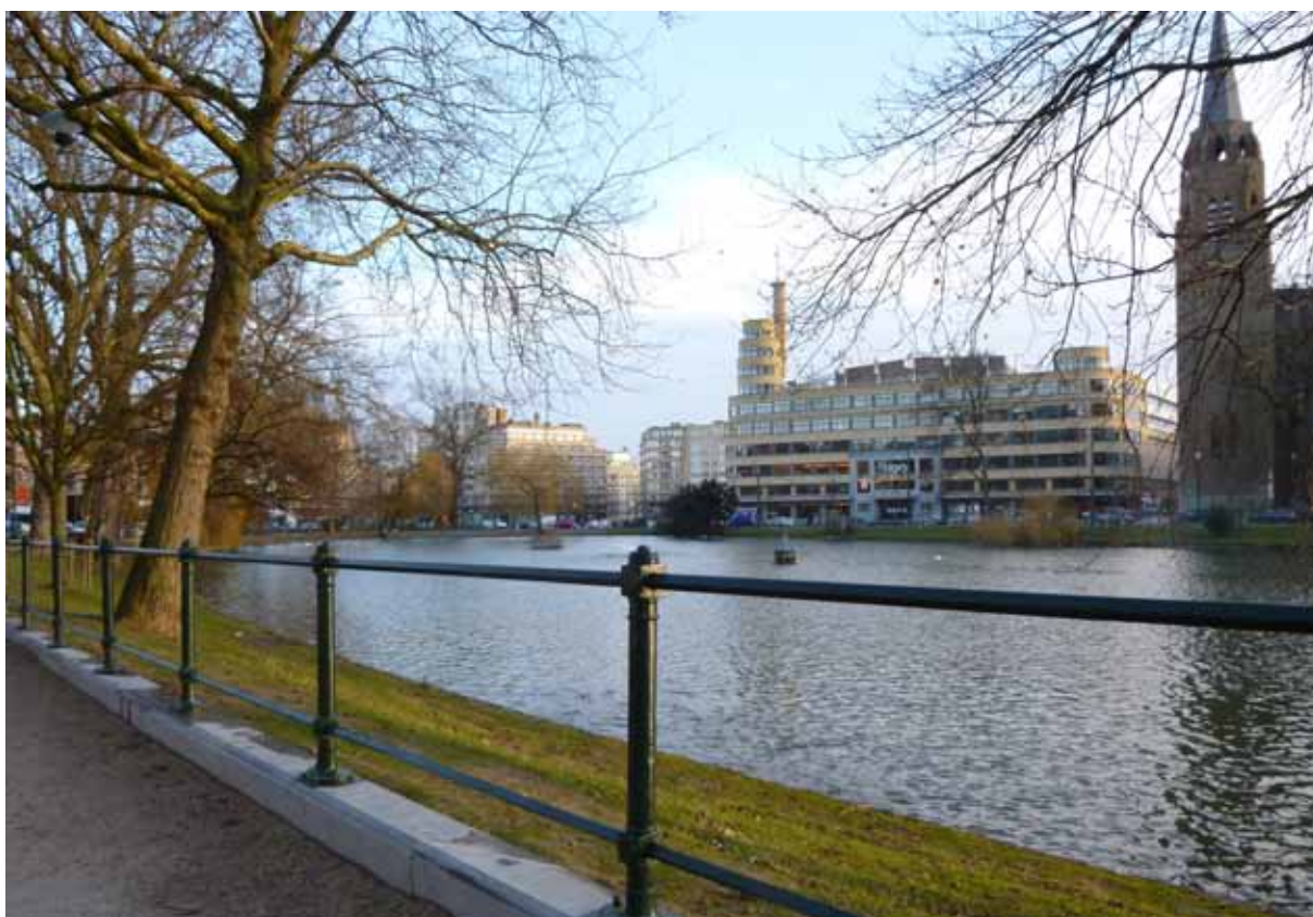
Les garde-corps des étangs d'Ixelles ont été restaurés en 2013 De balustrades van de vijvers van Elsene werden in 2013 gerestaureerd
