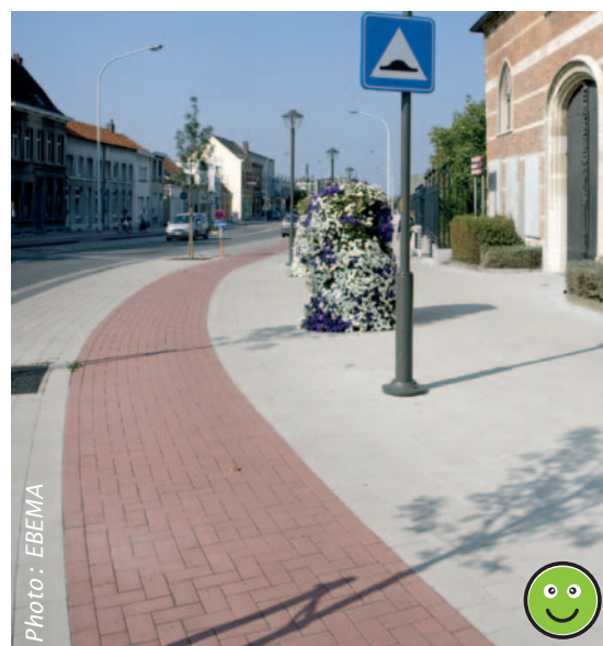
Bonne lisibilité de l'espace piéton et cycliste grâce à une coloration et des pavés en béton différenciés
