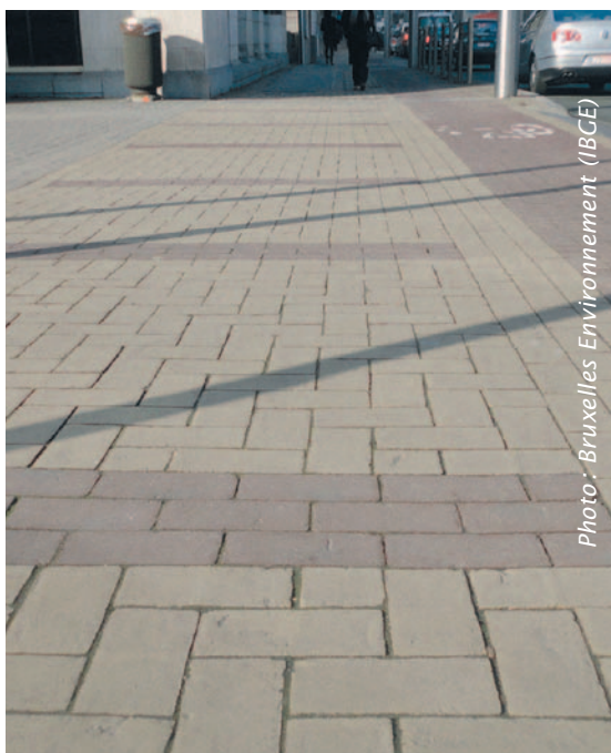
Revêtement en pavés de terre cuite (rue de la Loi à Bruxelles)
