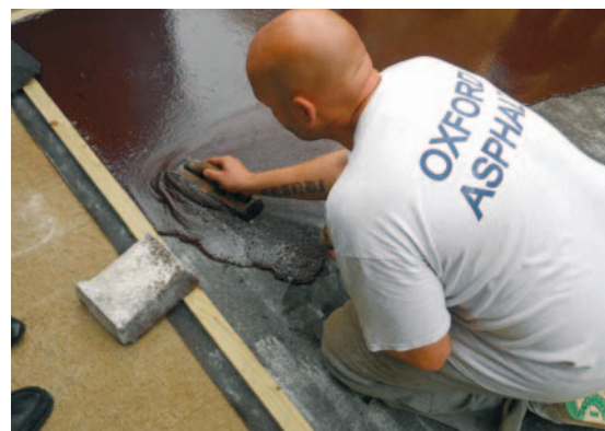
Talochage de l'asphalte coulé
