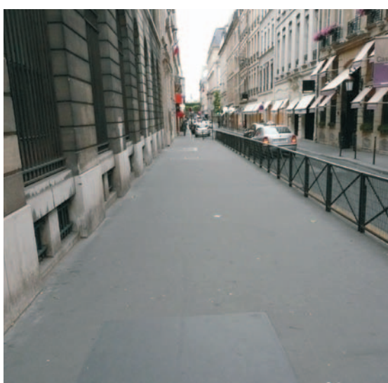
Revêtement bitumineux (asphalte coulé) utilisé à Paris
