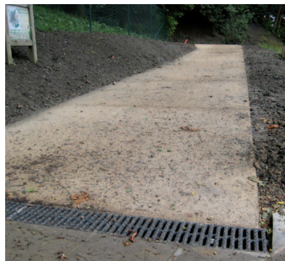
Béton désactivé pour les rampes d'accès à la promenade du chemin de fer à Woluwe
