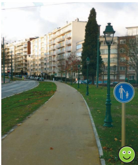
Revêtement piéton bitumineux coloré
