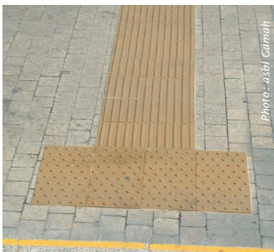
Revêtements podotactiles collés à froid
