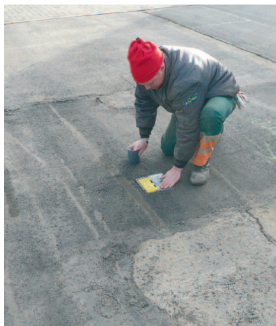
Protection du couvercle d'un équipement d'utilité publique avant traitement superficiel
