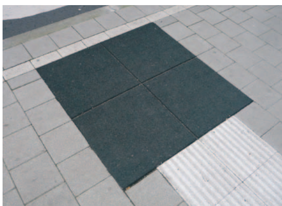
Revêtements en matériaux souples indiquant la présence d'une zone d'attente d'arrêt de bus
