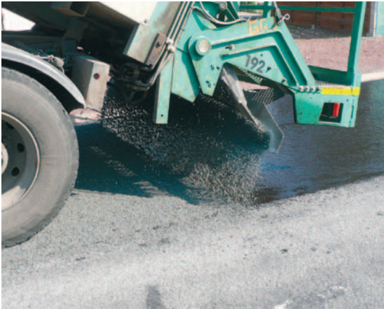
Épandage de gravillons sur la couche d'émulsion
