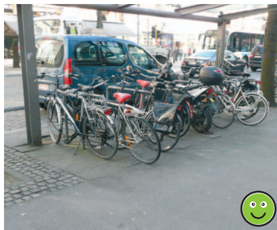
Zone de stationnement pour vélos en dalles de béton et cheminement piéton en asphalte coulé (gare centrale Anvers)
