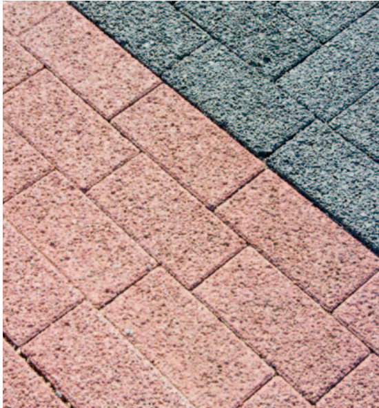
Revêtement drainant en pavés de béton poreux
