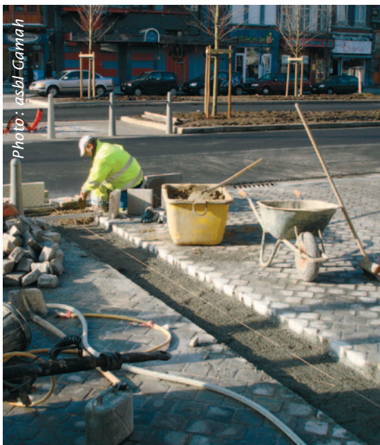
Placement de revêtements podotactiles en béton
