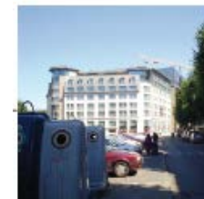
LES TERRASSES DU PARC (ETTERBEEK)
