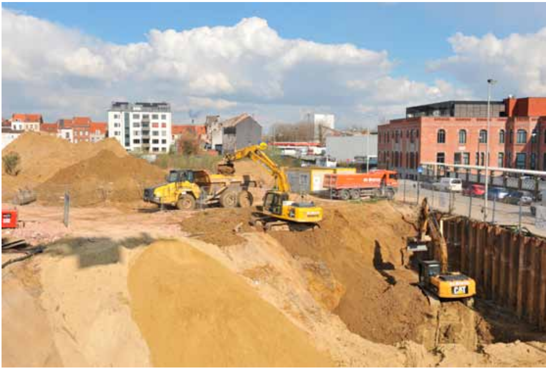
Excavation (sur une profondeur de 9 mètres) de terres polluées par le xylophène sur le site de l'ancien atelier d'imprégnation des Bois Brabant (projet Brussels Greenbizz à Laeken). Ontgraving tot op 9 meter diep van met xylofeen verontreinigde grond op de voormalige site van de impregneringsplaats van Bois Brabant (project Brussels Greenbizz in Laeken).
