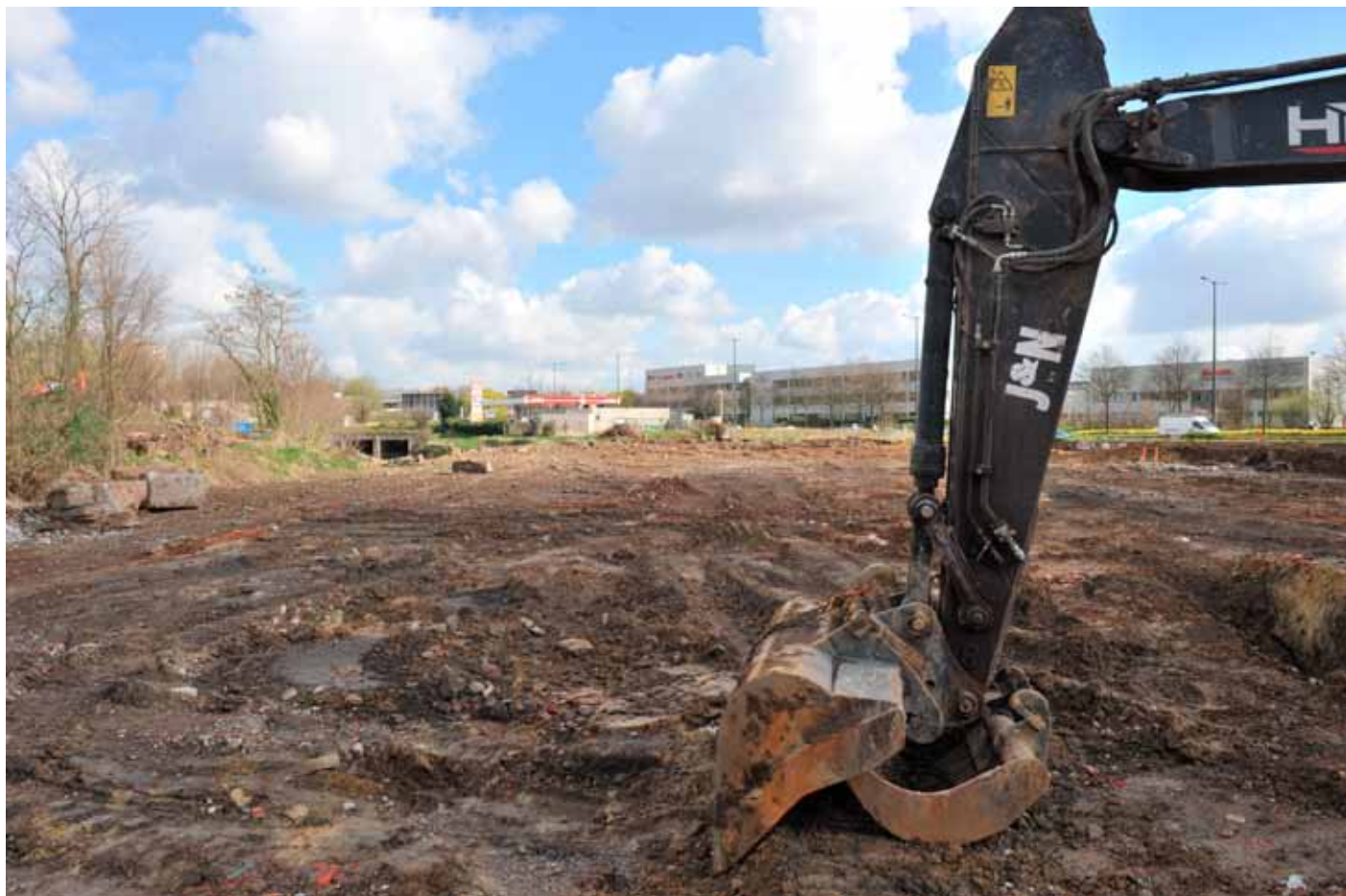
Pollution du sol en cours d'assainissement à Anderlecht. Bodemverontreiniging in behandeling op een site in Anderlecht.
