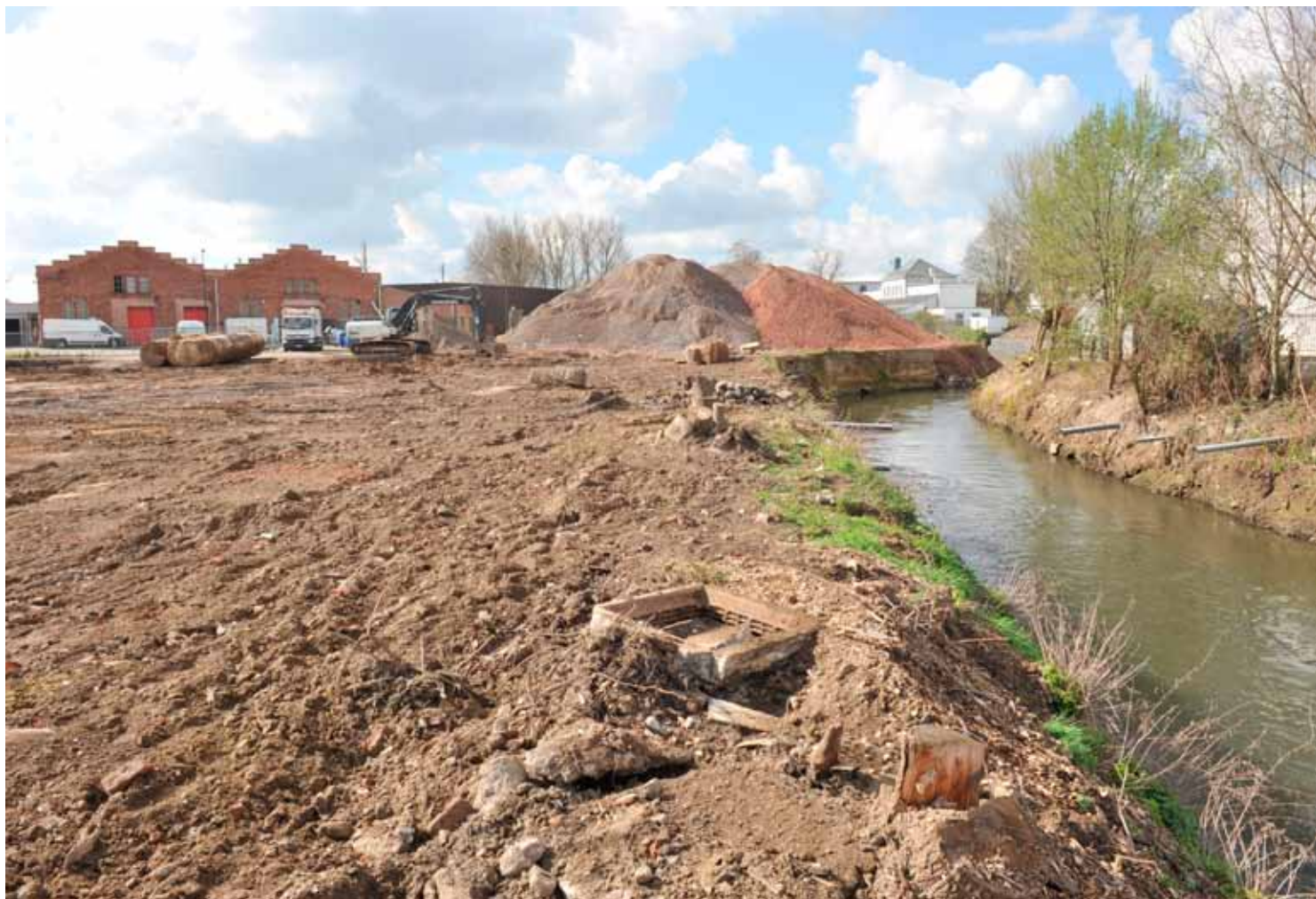
Nombre de terrains pollués sont localisés en fond de vallée. Le risque d'une dissémination de la pollution vers la Senne y est grand. Veel verontreinigde gronden liggen aan de valleibedding. Het risico dat de verontreiniging zich naar de Zenne verspreidt, is groot.
