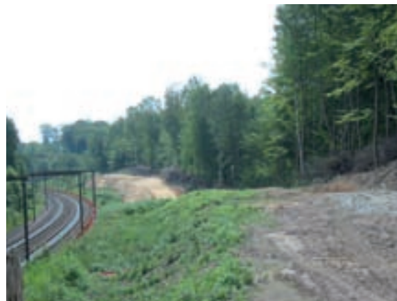
Elargissement de la ligne 161 (Bruxelles - Louvain-La-Neuve) en forêt de Soignes
