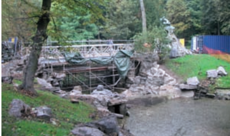
Parc Josaphat – Reconstruction du pont de Borée dans le cadre de la restauration du parc
