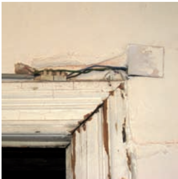
Raccords électriques très dangereux
