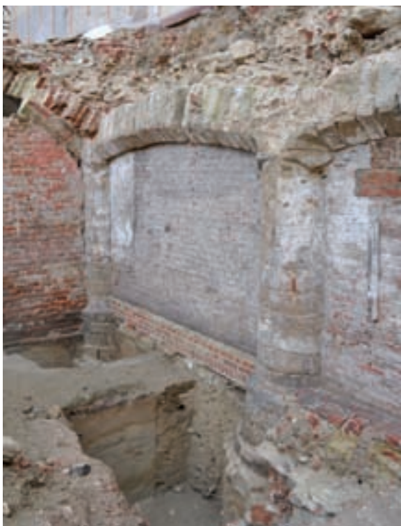
Dégagement de la cave voûtée du XV ème siècle, rue de l'Escalier, 34
