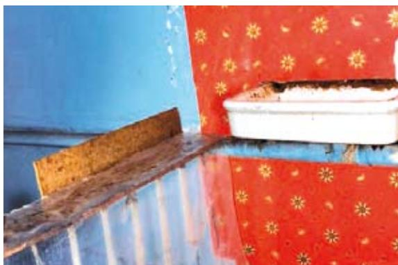
Lavabo collectif sur le palier, pas de siphon et branchement sur l'évacuation des eaux pluviales
