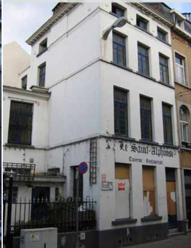
Foto 3 en 4 | Voorbeeld van een renovatie door een particulier in Sint-Joost-ten-Node. De vergunning staat de realisatie van een bijkomende woning toe d.m.v. de herbestemming van een handelszaak op de benedenverdieping en de opsplitsing van de woning op de verdiepingen.
