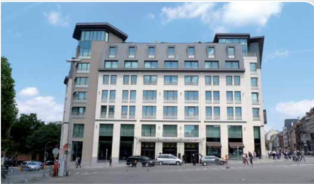
Photo 6 | L'hôtel situé place Jourdan est un des principaux nouveaux hôtels. Situé aux alentours du quartier européen, il abrite 150 chambres.
