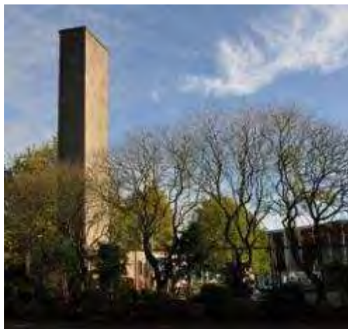
Afbeelding 65: actuele foto van de schoorsteen van het ketelhuis (APEB, 2011)
