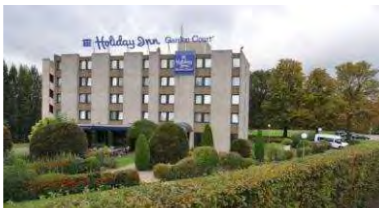
Afbeelding 68: foto van het huidige hotel (APEB, 2011)
