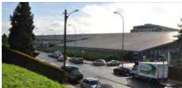
Afbeelding 84: parking en brug (APEB, 2011)
