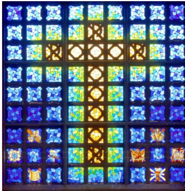
Glas-in-lood in in betonframe boven het koor
