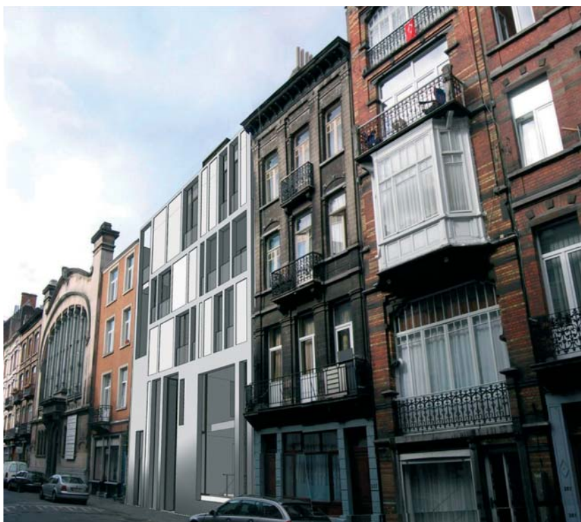
Procedure georganiseerd door de gemeente Schaarbeek voor het project Huis van de Vrouw, winnaars: de bureaus Zed en Gigogne
