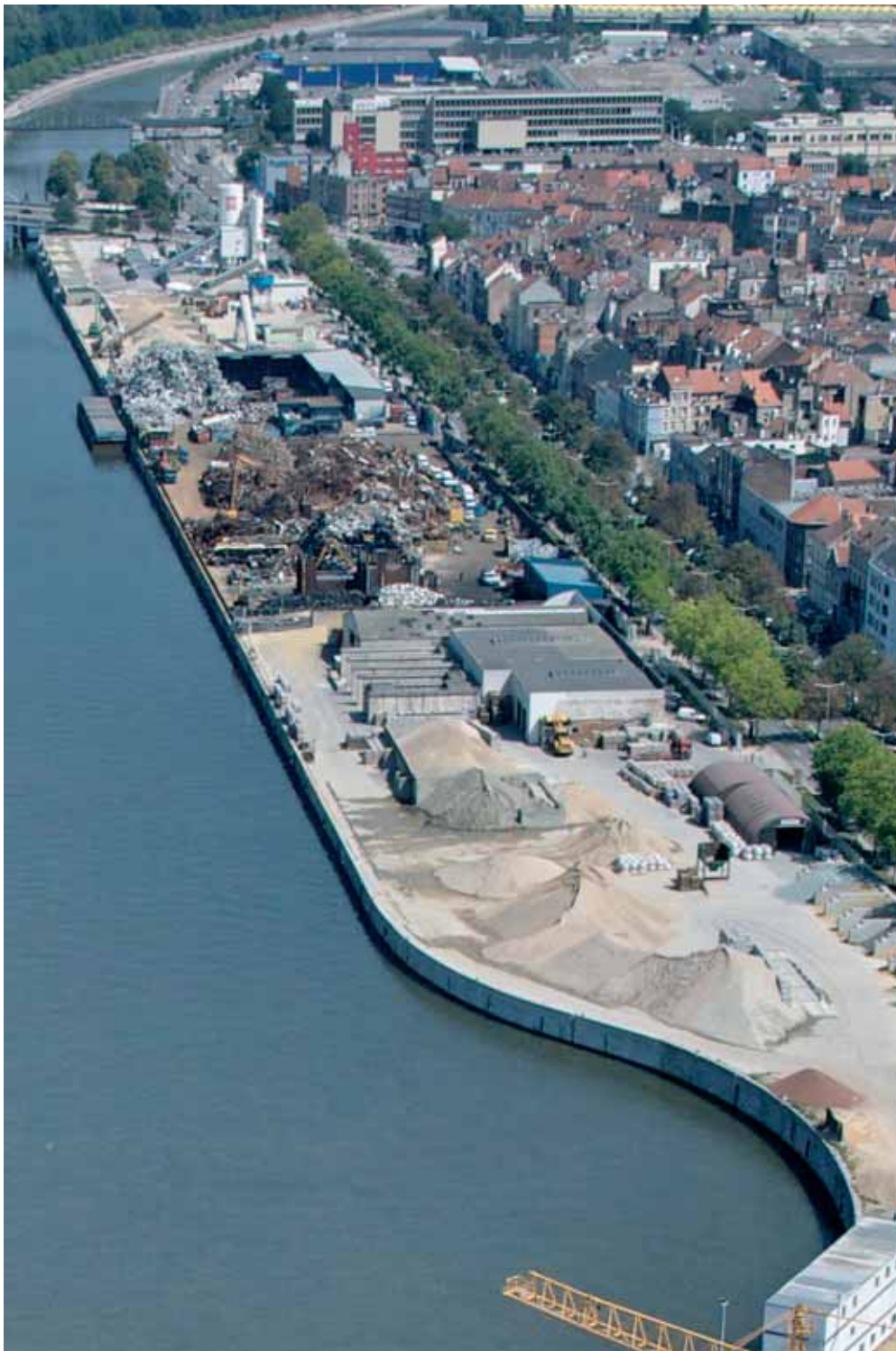
Cette vue aérienne du bassin Vergote, et de l'Allée Verte, montre bien la complète occupation de ses quais. Op deze luchtfoto van het Vergotedok en de Groendreef is duidelijk te zien dat de kades volledig worden gebruikt.
