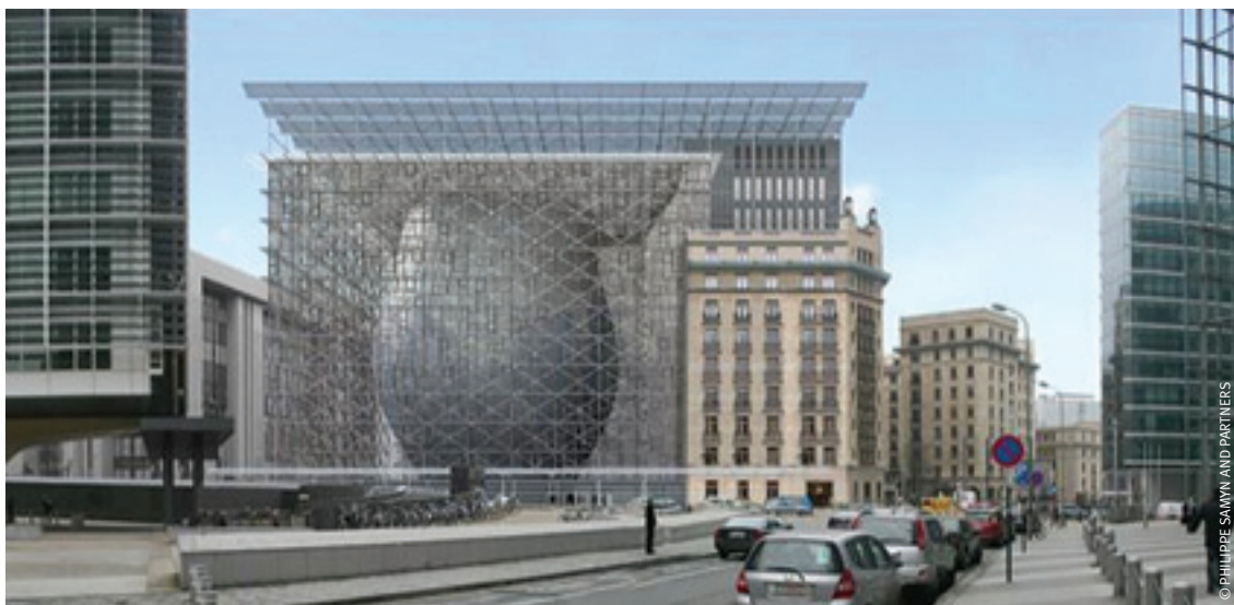
Restauratie en verbouwing van het 'Residence Palace' met als doel er de zetel te vestigen van de Europese Raad en van de Ministerraad van de Europese Unie (Brussel-stad) - Vergunning afgegeven in mei 2008, naar aanleiding van een stedenbouwkundig attest, afgegeven in november 2007 (met effectenstudie). - Arch.: PH. Samyn and Partners
