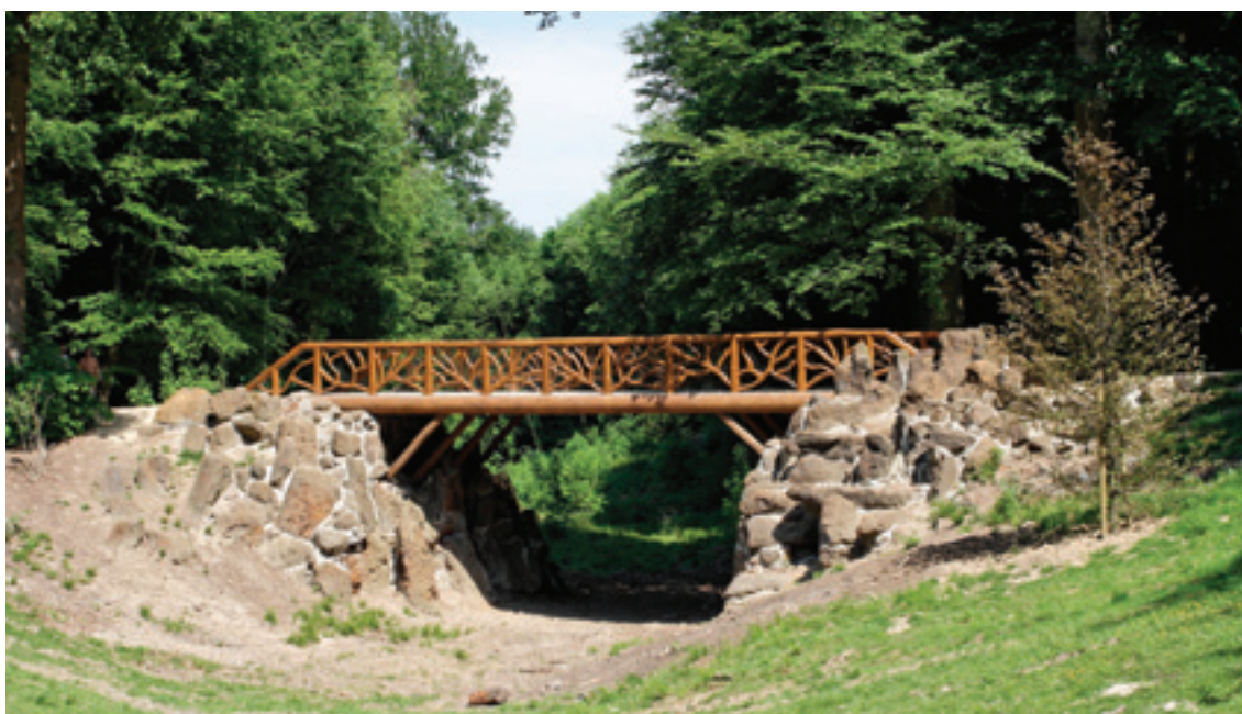
Heropbouw van de Duivelsbrug in het Terkamenbos, in het kader van de Beliris-akkoorden
