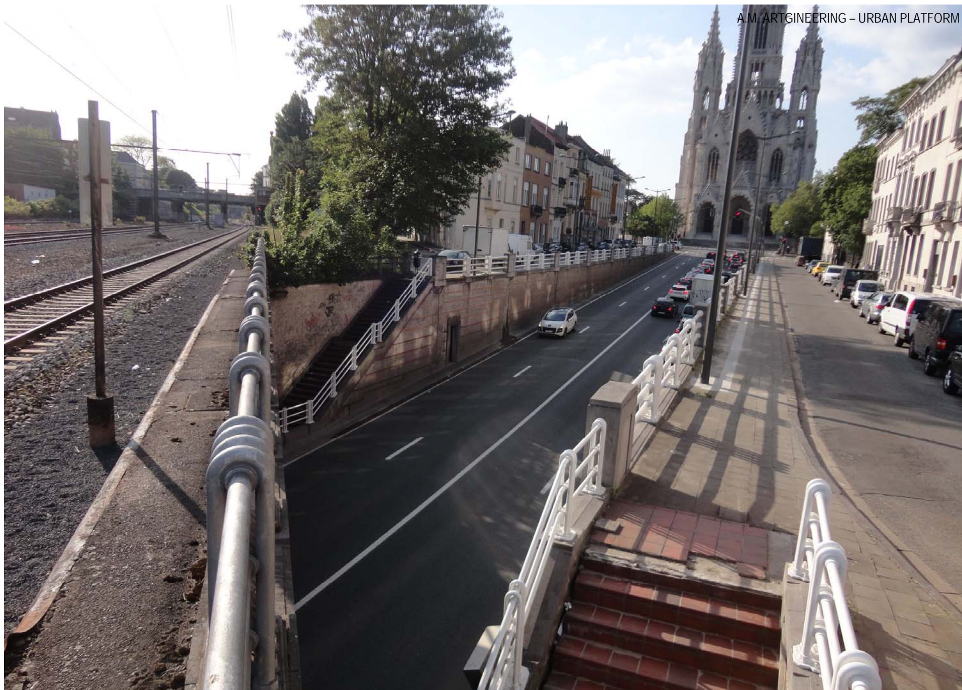
Passerelle Avenue de la Reine (EP6) Passerelle Koninginnelaan (EP6)
