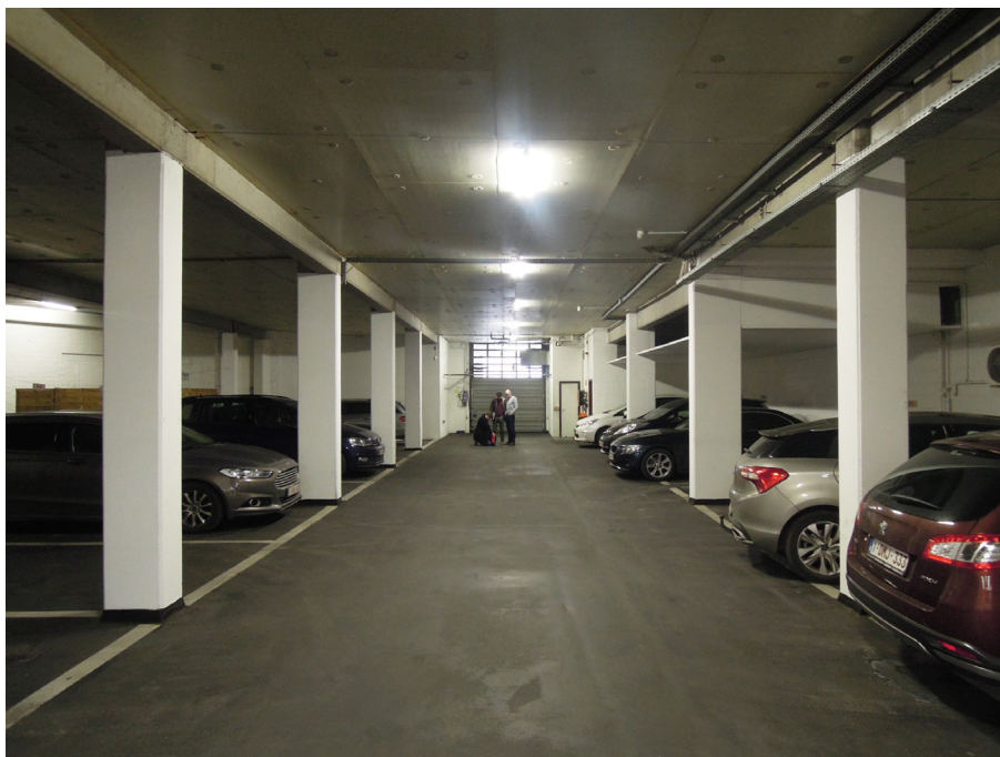
Photo 4 Vue du parking sous l'immeuble, qui sera reconverti en préau.
