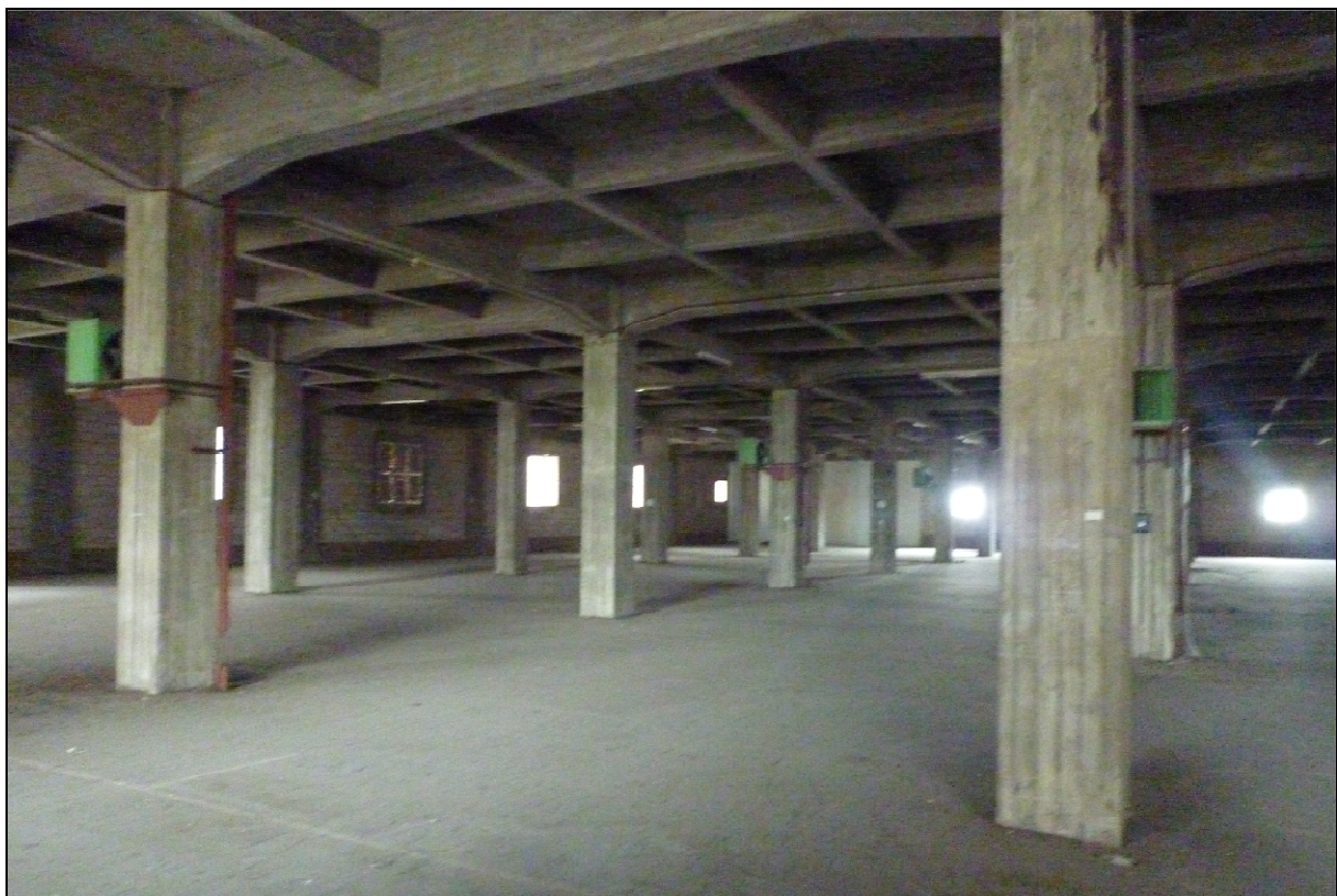
Foto 6 : Aanzicht van de binnenkant van het St-Michel-gebouw en de structuur ervan
