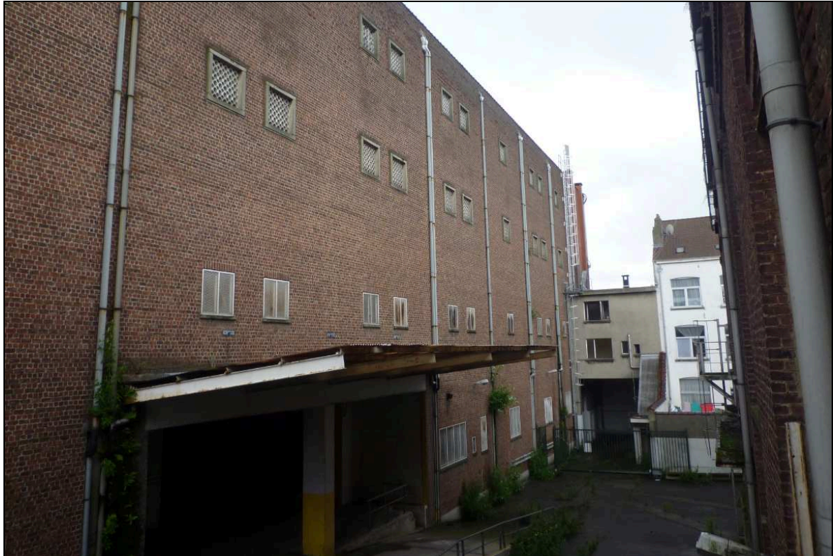
Foto 5 : Zicht op de gevel van het St-Michel-gebouw, kant binnenplaats
