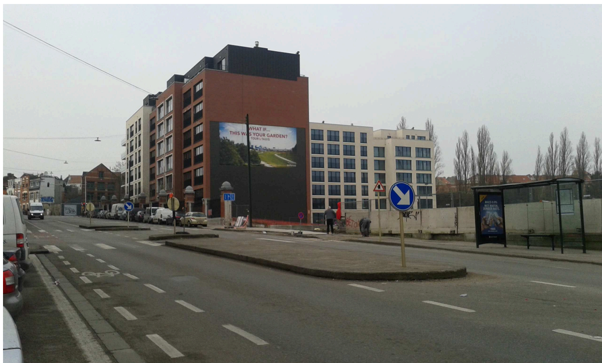
Foto 7 : Zicht vanaf het dak van het St-Michel-gebouw naar het woningengebouw in de bouwfase op de locatie van Tour en Taxis (September 2016)
