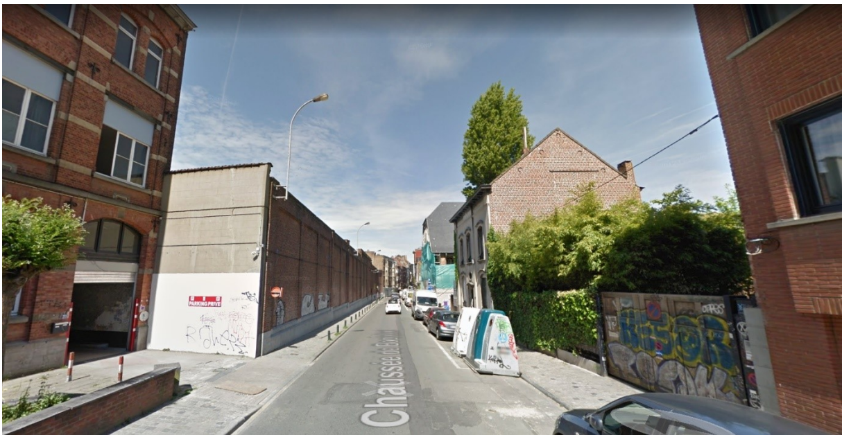
Chaussée de Boondael – vue vers le centre à la hauteur du n°277
