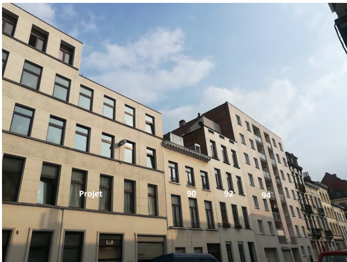
Figure 19 : Photo des bâtiments donnant sur rue (ABO)
