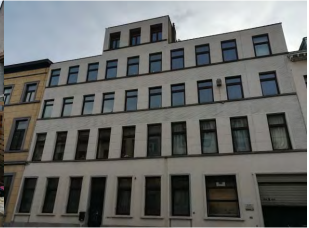
Figure 6 : Façade des numéros 82 à 88 (bâtiment B) (ABO)
