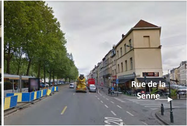
Figure 23 : Boulevard de l'Abattoir (Source : Google StreetView, mai 2017)
