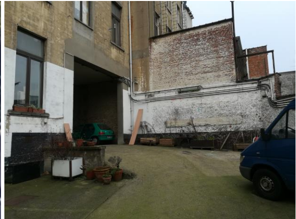
Figure 31 : Cour intérieure (ABO)
