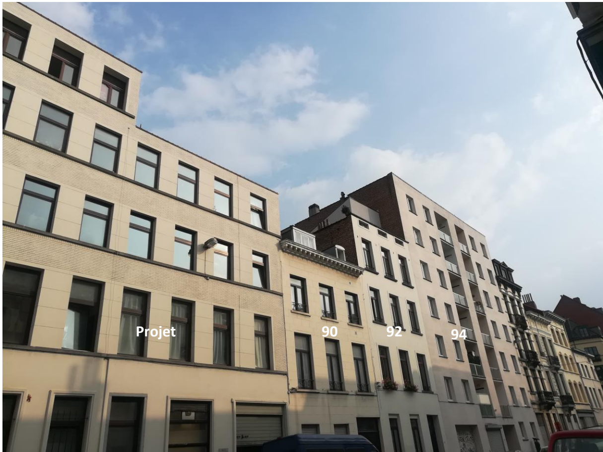
Figure 19 : Photo des bâtiments donnant sur rue (ABO)
