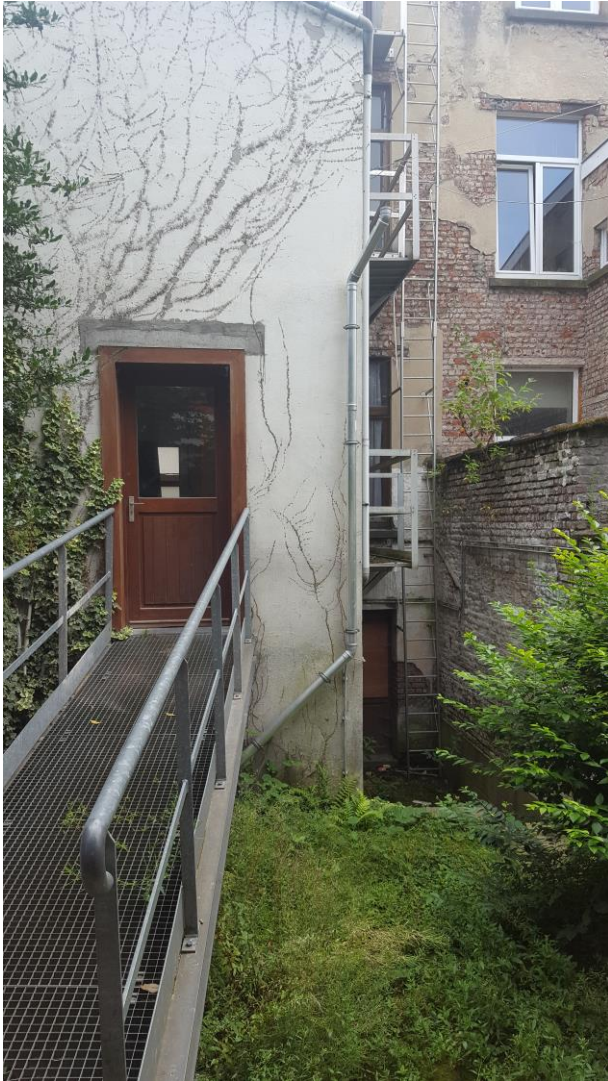
Vue 6 (Façade Arrière)
