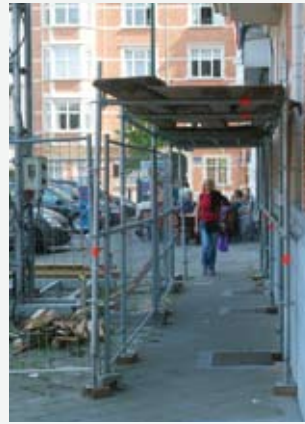
Couloir de protection contre la chute de matériaux.
