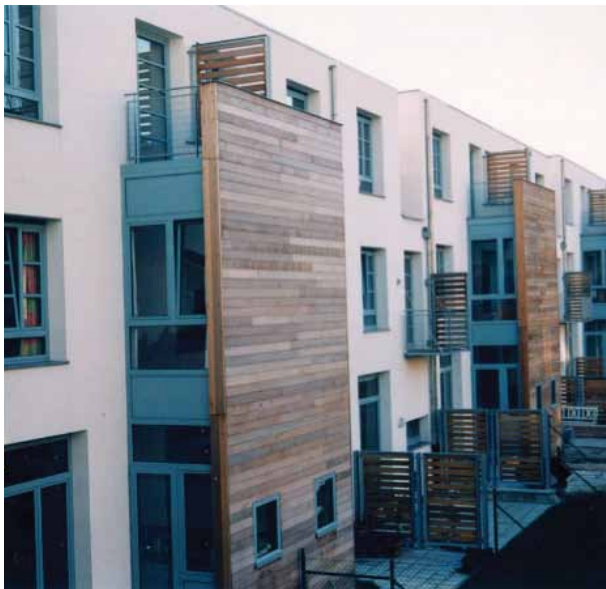
Ensemble de maisons rue Verrept Dekeyser à Molenbeek, visible dans la balade ARCHI-AUDIO (1999-2003). Les enduits n'ont jamais été réceptionnés pour cause de malfaçon. Arch. Pierre BLONDEL
