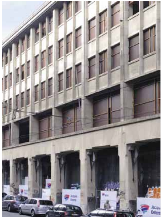
Cet immeuble de bureaux de la rue Royale a fait l'objet de deux permis de démolition/reconstruction. Le premier en 2008, conservant l'affectation bureaux, le second en 2011 de conversion en hôtel.
