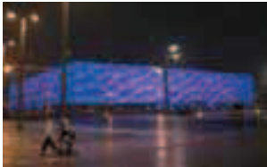
piscine (water cube, Pékin)
