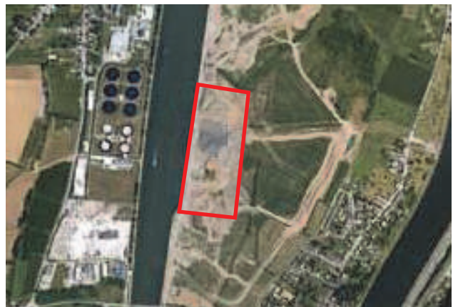
LIEGE: chantier pour Liège Trilogiport
