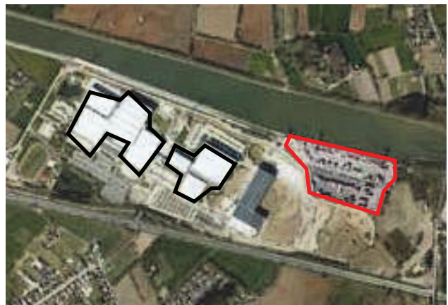
GEEL: centre logistique NIKE (VAL), avec terminal à conteneurs intégré
