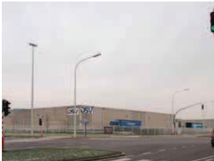
Construction le long de la rue du Lion: des façades aveugles et des grillages, un aménagement des abords peu soigné.
