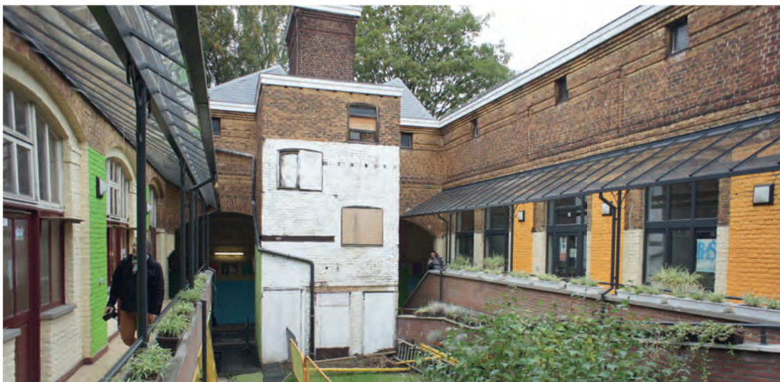
V.05 Cour intérieure du bâtiment Optima
