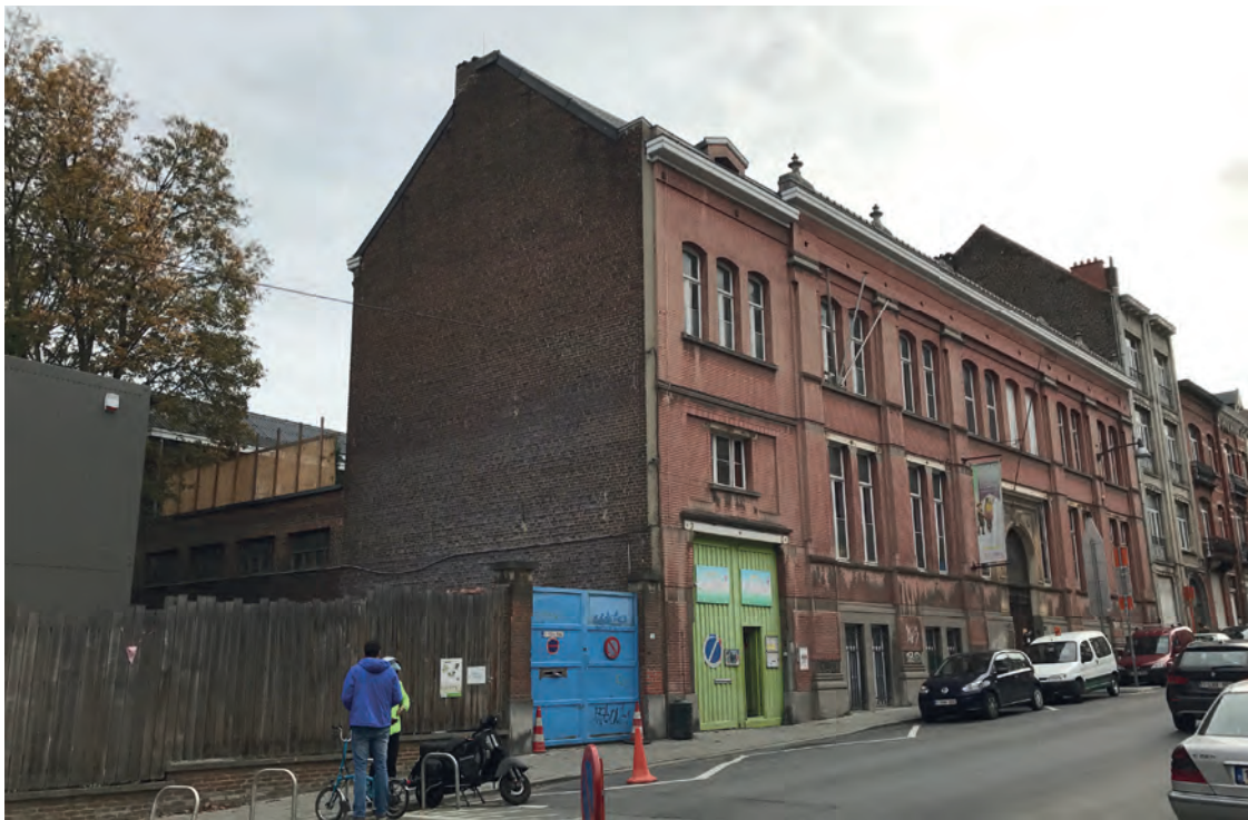
V.03 78-80 Grande rue au Bois / Bâtiment Optima
