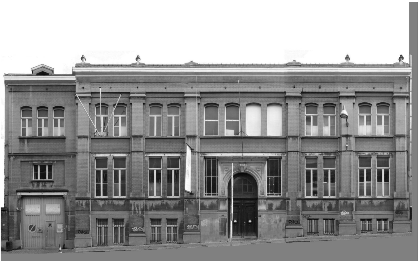
72 Vue actuelle redressée de la façade
